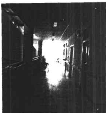
03 ทางสัญจรภายในอาคาร
