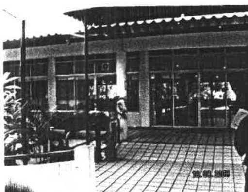
02 ทางเชื่อมไปสู่อาคารเอนกประสงค์
