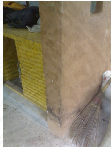
(ข) กำแพงที่สร้างบนพื้นคอนกรีต
